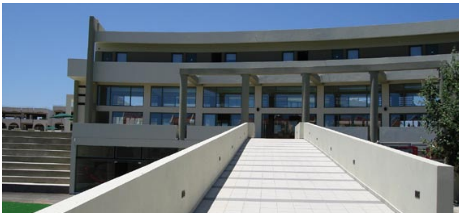
Εναέρια γέφυρα πρόσβασης στη νέα μονάδα
