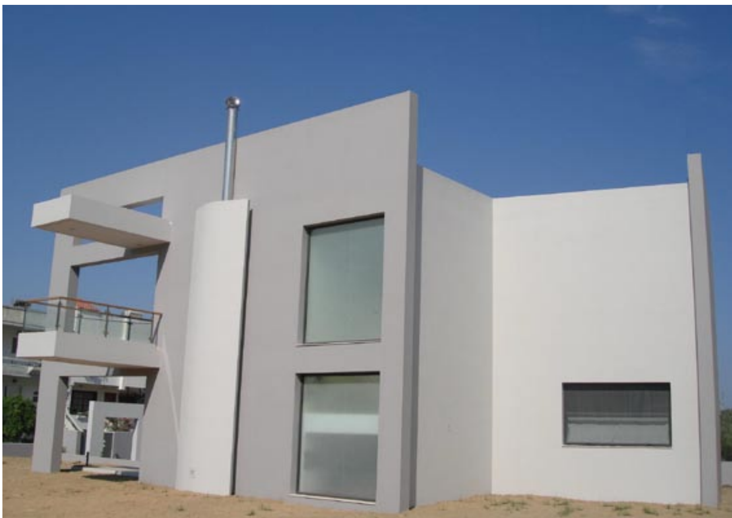
Άποψη των κατοικιών από την παρακείμενη οδό Βορειοανατολική άποψη
