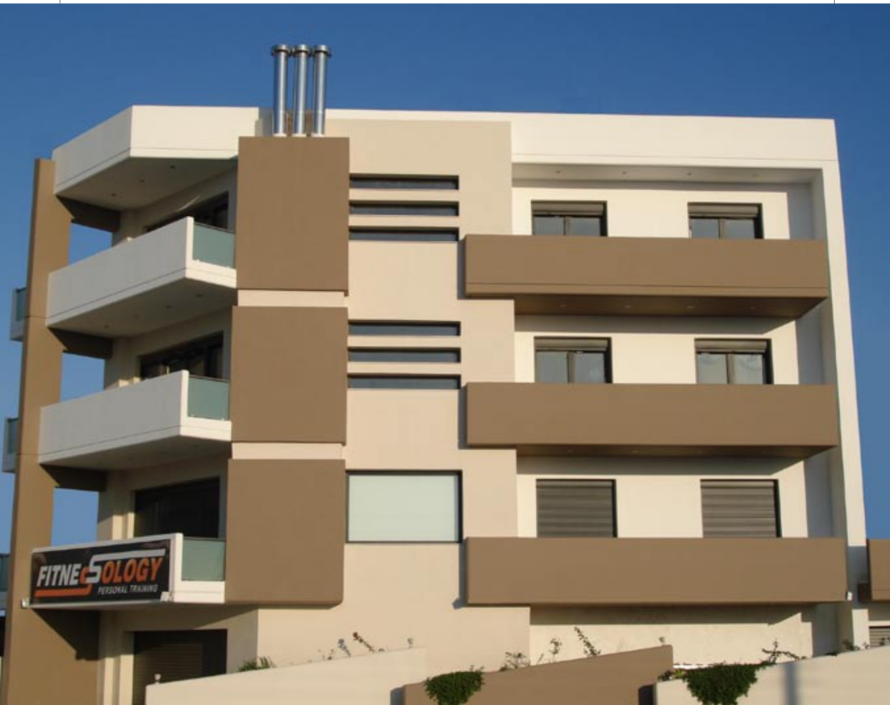
Δυτική όψη του κτιρίου
