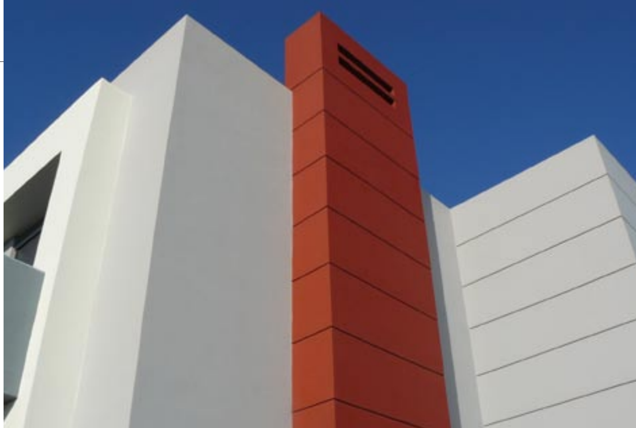
Άποψη καμινάδας τζακιού
